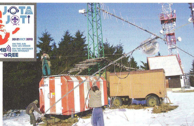
Obr. 2. Skauti z RK OK1RSJ stavějí anténu na Suchém vrchu, lokátor JO80IB (995 m n. m., rovněž QTH FM převaděče OK0F v pásmu 145 MHz). Yagi je typu F9FT pro pásmo 70 cm, SBF (Short Backfire Ant.) pro pásmo 23 cm. Na střeše buňky je Mirek, OK1UVU, dole roveří Dominik a Dan
